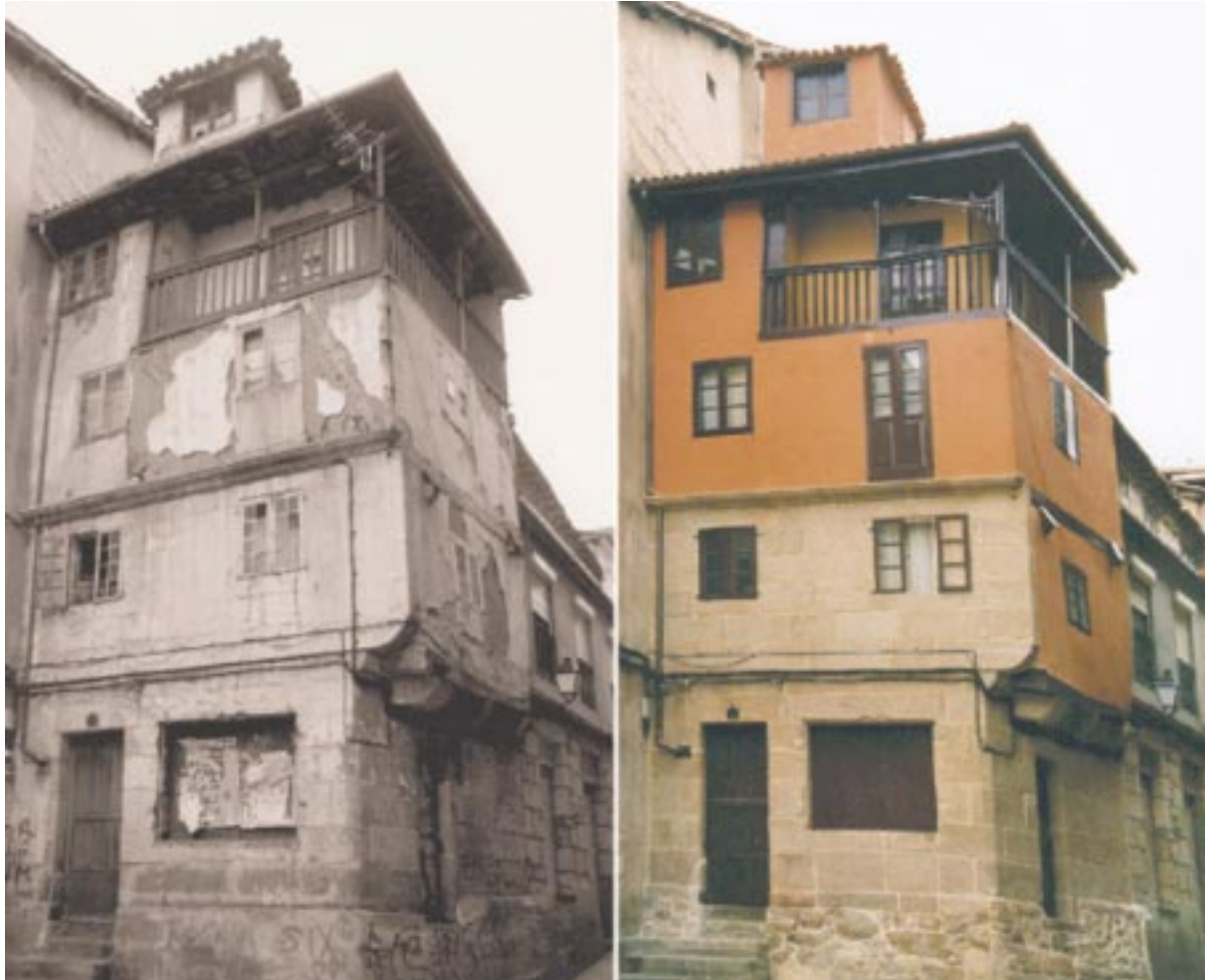
Rehabilitación de viviendas. Antes y después de la actuación.
