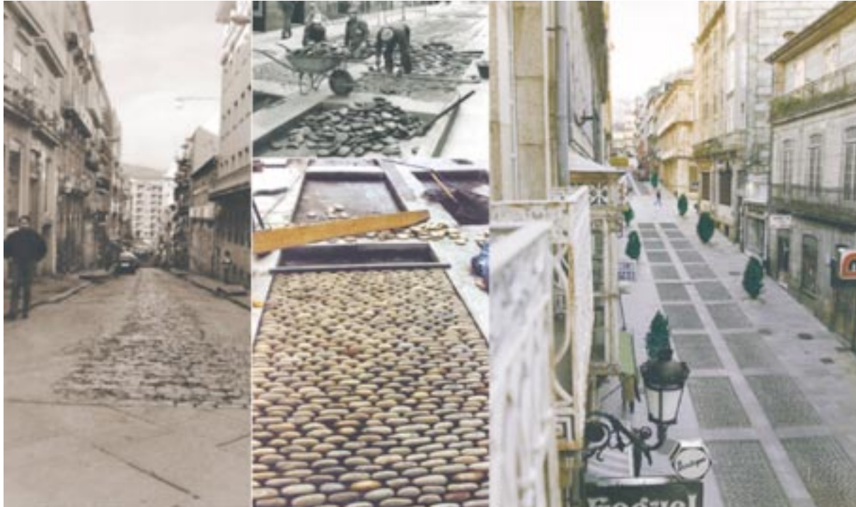
Rehabilitación de infraestructuras. Calle Cardenal Quiroga
